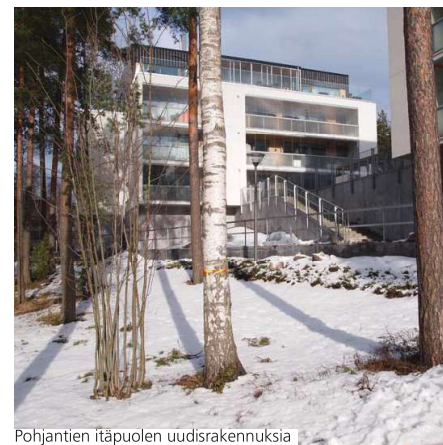
Pohjantien itäpuolen uudisrakennuksia
